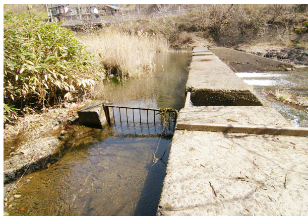
小水力発電取水予定地
